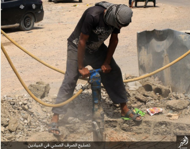
تصلب الصرف الصحي في الميادين
